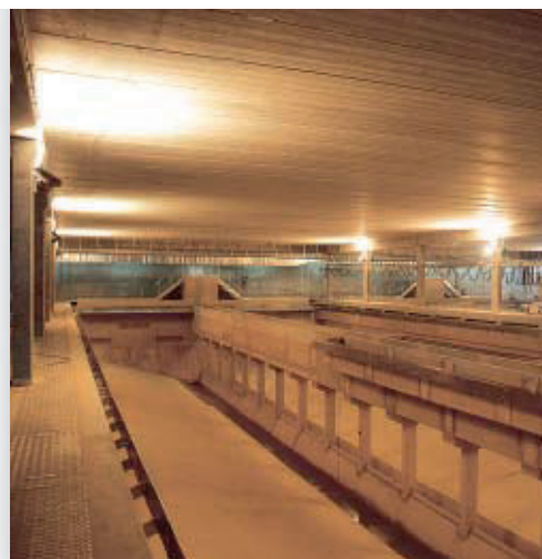
▲ Station d'épuration de Bonneuil.
